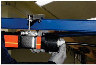
Apretar el cable eléctrico gracias al prensaestopas que lleva dicha cubierta. Verificar que el cable se instala con holgura, a fin de que pueda asumir posibles contracciones y dilataciones de la línea.
