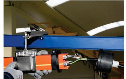
Realizar la acometida eléctrica a la línea en el extremo. Si la acometida se realiza en la parte central de la línea, se sustituye un empalme por una alimentación intermedia AI-4 realizando la acometida eléctrica en dicho punto.
