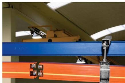
Instalar las barras de línea LM-4 en los puntos de soporte respetando que la línea amarilla de señalización de "tierra" queda siempre al mismo lado.
