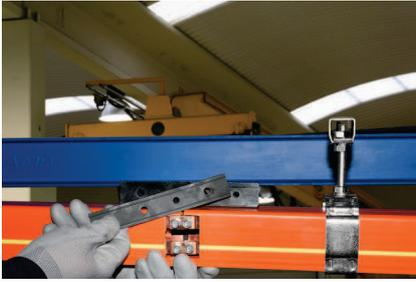
Cubrir las conexiones con los empalmes EMP-4, cuidando de que los laterales queden bien encajados en la parte baja del perfil de PVC. La junta central ha de quedar montada entre ambos laterales.
